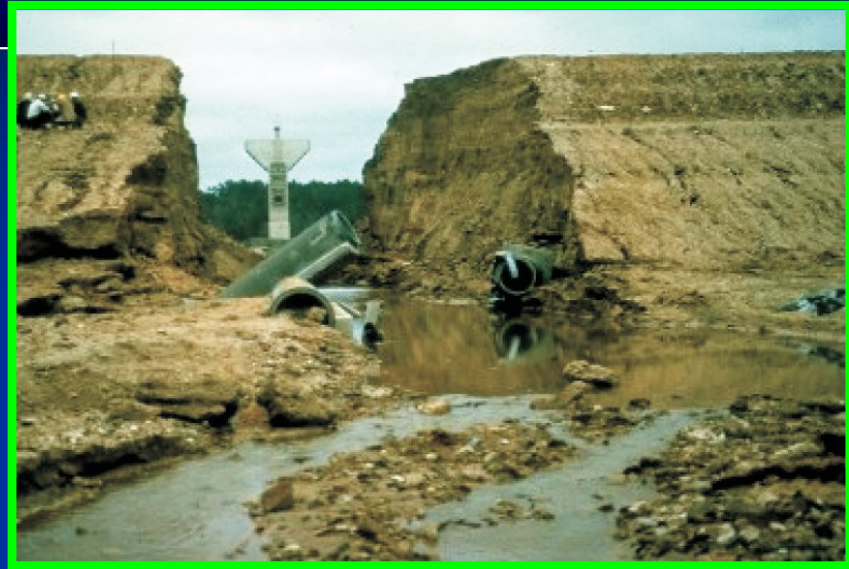
2. การกัดเซาะภายใน (Piping)
